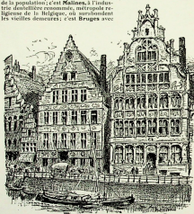
Gand. — Maisons des Francs Bacheliers, quai aux Herbes.
